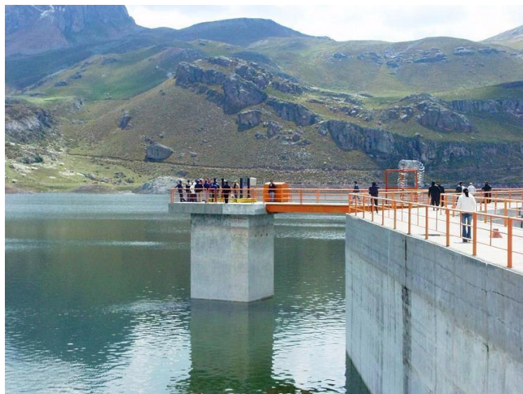
Figura 4. Agua recolectada en Marcapomacocha para el consumo de la población de Lima y producción de energía eléctrica.
