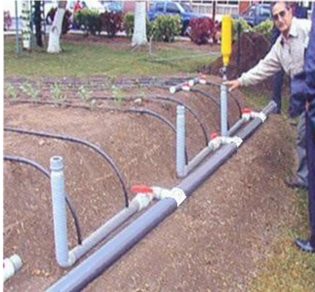
Figura 93. Maqueta - Tubería secundaria y portallateral.
